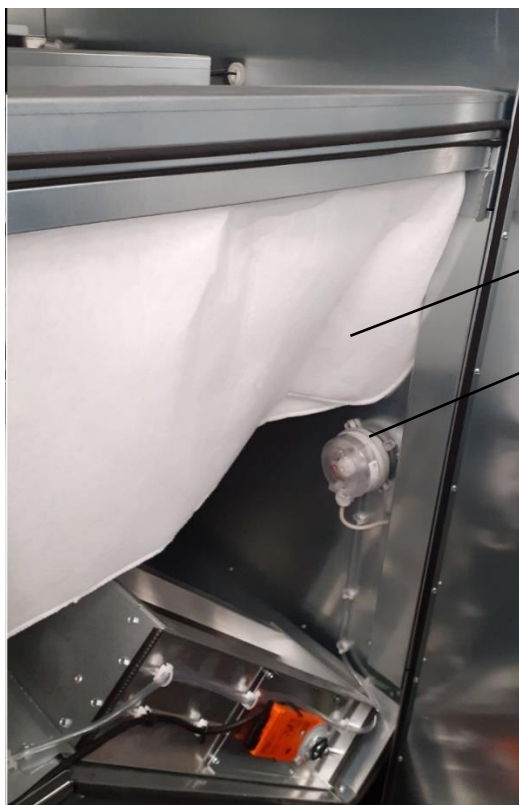
Afb. 15 Plaatsing van de manostaat, rechtsgeplaatste uitvoering van de CPV-unit
