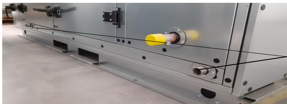
Afb. 4 Plaats van aansluiting van de sifon
